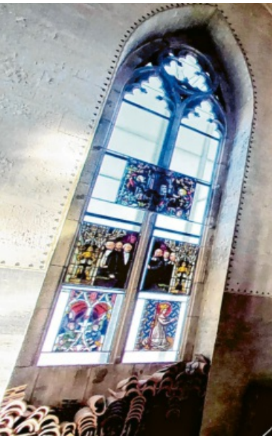
Dies ist einer der Glasschätze, die in der Christuskammer nun restauriert und gesichert werden konnten.
